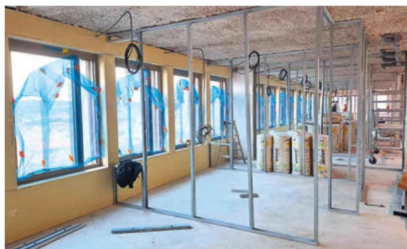
Rapide à mettre en œuvre, l'ossature métallique ID4 est utilisée sur tous les plateaux pour le cloisonnement.
